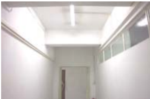
光管加裝反光膠片
